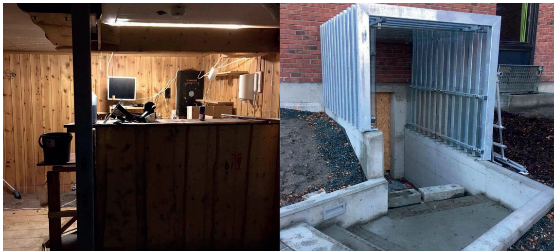
Ny bar og nytt inngangsparti skal ferdigstilles før kjelleren åpnes.
